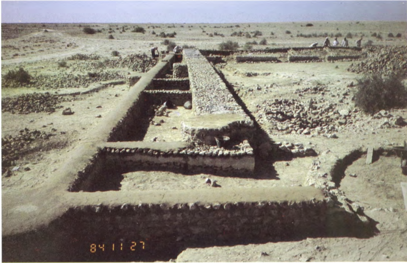
مروب - المرحلة النهائية لأعمال الترميم والتدعيم لكل من الجدار الجنوبي المستعرض للقلعة الثانية والجدار الجنوبي للقلعة الأولى
